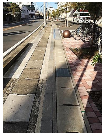
側溝が横並びに医療センター前
