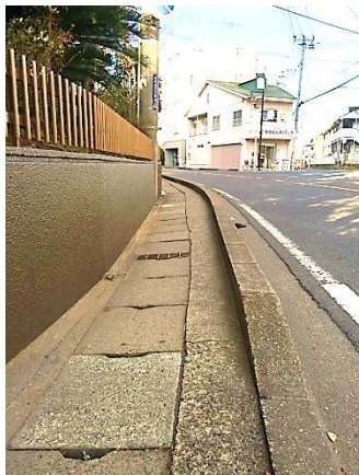
歩道の幅が狭い市川市との境付近
