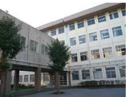
棟棟 生徒棟 管理棟 廊下 正面 玄関 前（左）
