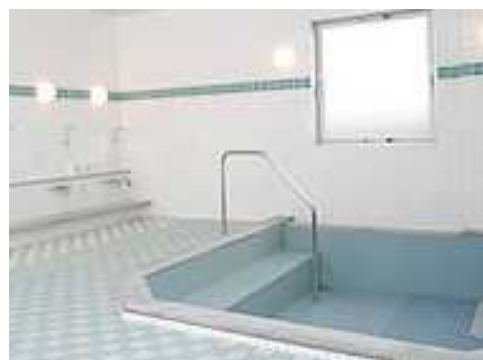
法定水質検査が行われていなかった浴室(うら・らめ〜る内) 検査結果は菌の検出はなしと判明
