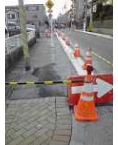
工事中の市道1-68号線
