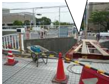
工事中の仮設歩道橋 (8月20日)
