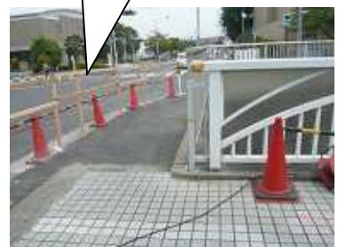
工事中、片側一車線 通行となる車道
