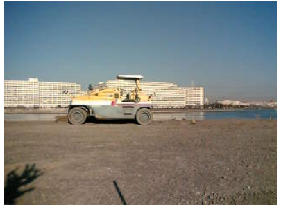
開放にむけて工事が進む舞浜地区前面護岸(07年1月)
